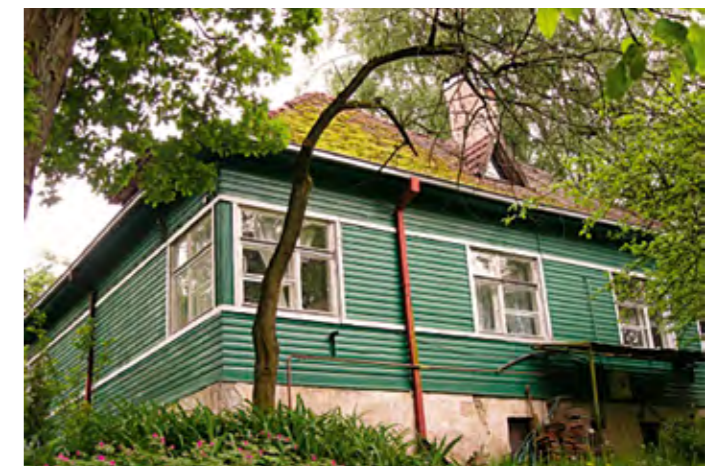
366. A wooden modernist villa on 35 Perkūno Alėja. Photo: archimede.lt, 2009
