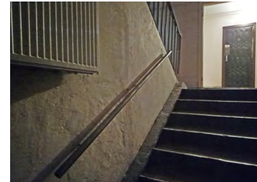
Laiptai su turėklų pakeliui į liftą mano laiptinėje, Savanorių pr. 281 A staircase with a handrail on the way to the lift in my building at Savanorių Ave. 281
