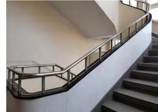
Metalinis turėklas Kauno klinikose Metal handrail at Kaunas Clinics
