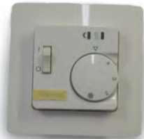
Grindų šildymo reguliatorius (netiko) Floor heating control (never fitted)
