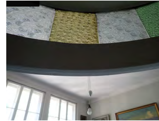
Durų rėmo viršus su išlenktu vitražu ir raštuotais stiklais Door-frame top, featuring curved stained glass with imprinted patterns
