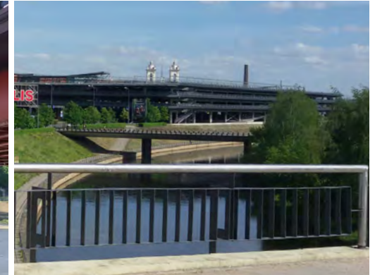
Vaizdas nuo Simono Daukanto pėsčiųjų tilto View of Simono Daukanto Pedestrian Bridge
